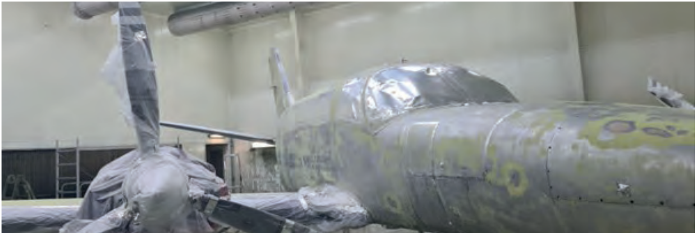
Abdeckung vor dem Aufbringen des Primers
