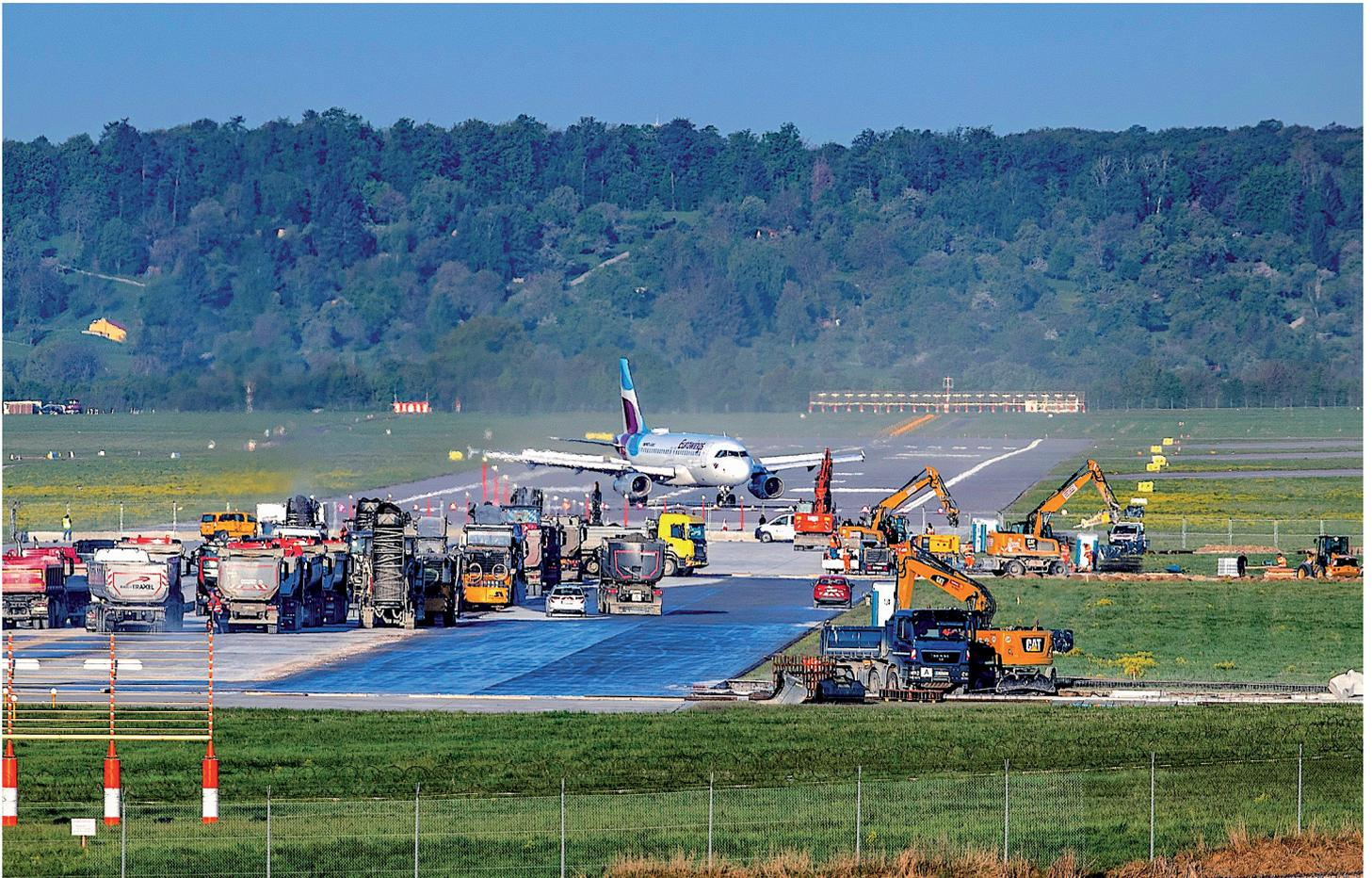
Abb. 1: Wenn eine ausreichend lange „Restpiste“ zur Verfügung steht, so ist wie in Stuttgart eine Pistensanierung bei laufendem Betrieb möglich (Foto: FSG)
