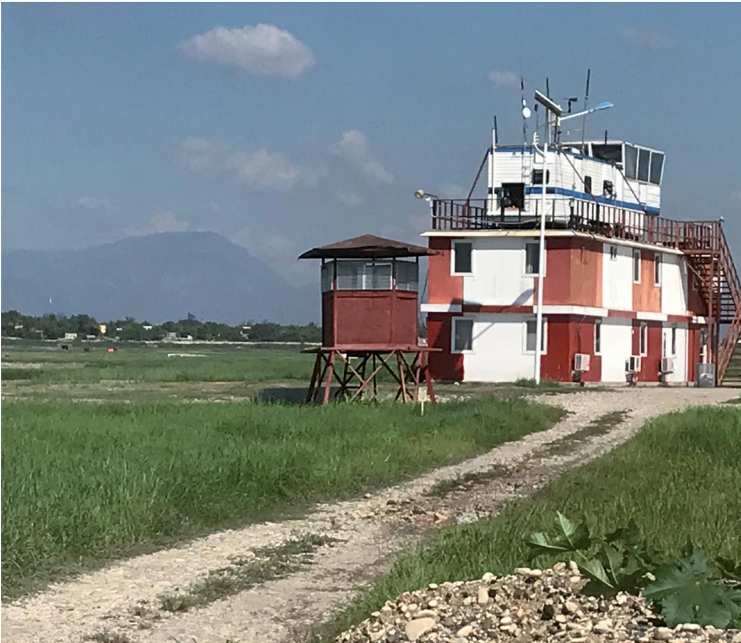
Abb. 4: Haiti TWR 6\_Philippe\_Domogala: Die Sicht wird zur Piste 10 wird zusätzlich durch die auf dem Wohnwagendach angebrachten Antennen eingeschränkt
