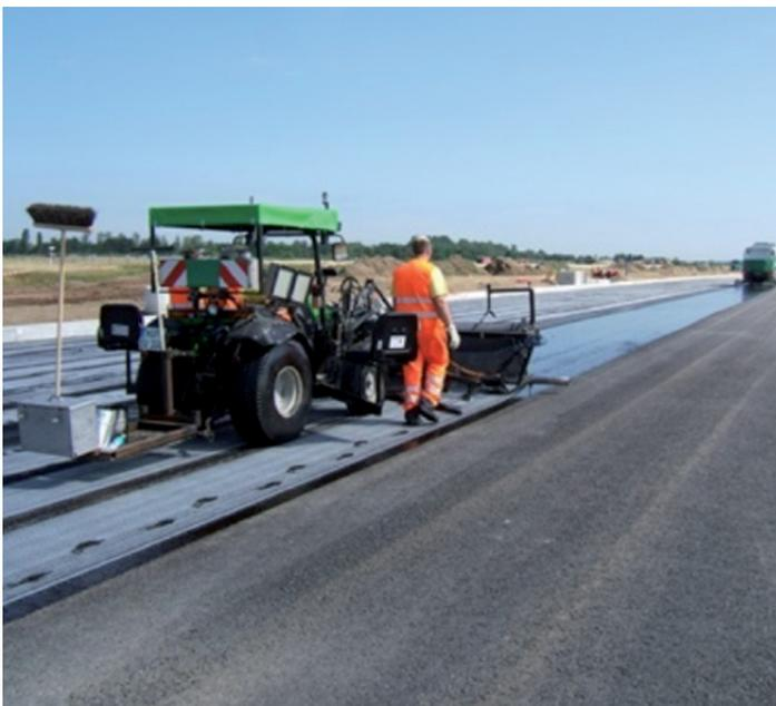
Abb 21: Einbau einer Asphaltbewehrung in eine Piste
