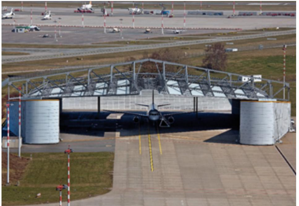
Abb 6: Lärmschutzhalle geöffnet
