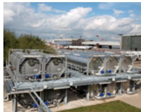
Abb 3: Oberirdische Tanks für Flugzeugenteisungsmittel
