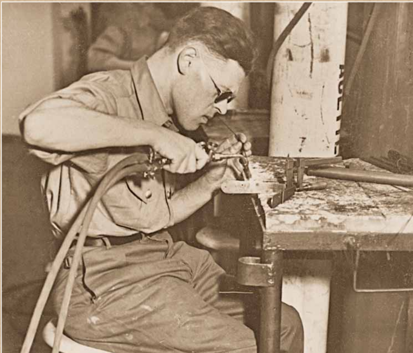
Bild 1. Schweißen beim Segelflugzeugbau
