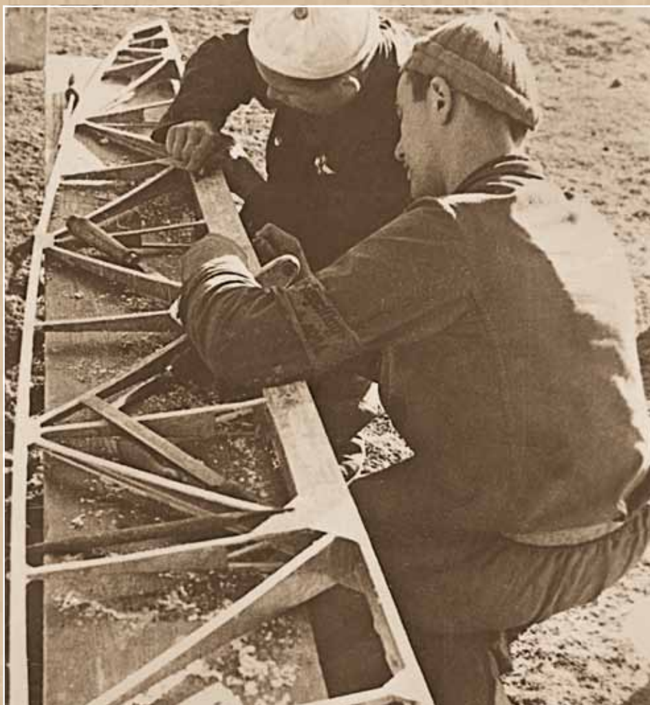
Bild 2. Reparatur eines Querruders
