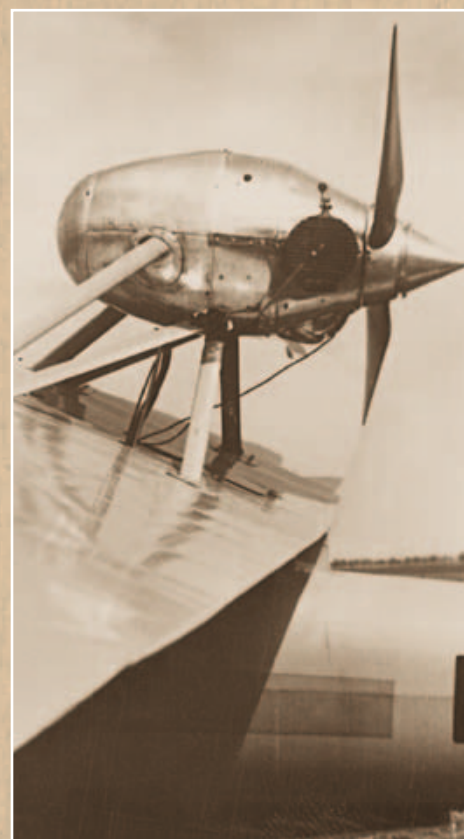
Bild 8: Segelflugzeuge mit Hilfsmotor: Der Außenboard-Motor des Segelflugzeuges
