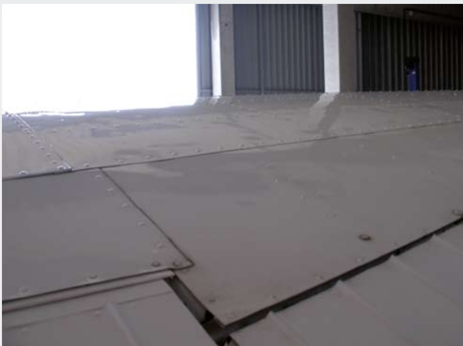
Abbildung: durch Hagelschlag beschädigte rechte Tragfläche
